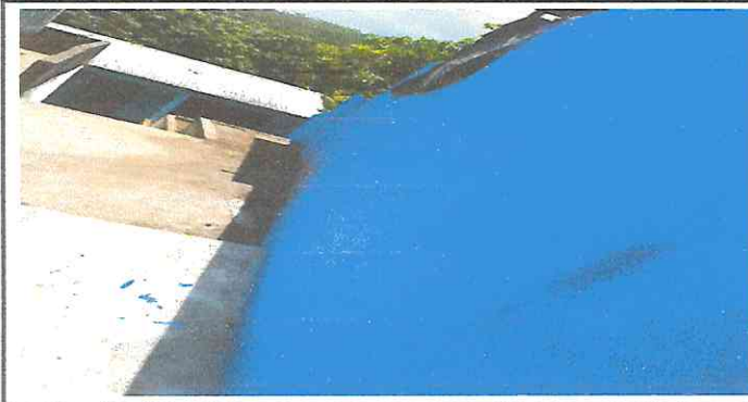
Foto 3: MEJORAMIENTO DEL MURO PERIMETRAL Y APLICACIÓN DE PINTURA
