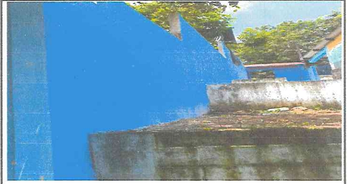
Foto 2: LEVANTAMIENTO DE BLOCK AL MURO PERIMETRAL Y PINTURA
