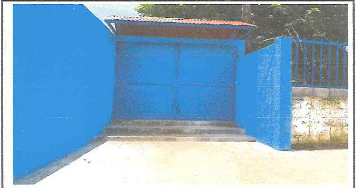
Foto 4: SUSTITUCIÓN DE PORTON METALICO Y PINTURA
