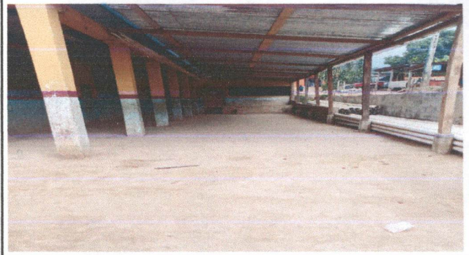
Sustitución de área de cocina
