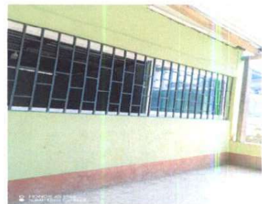
Foto 6: Ventana de Cocina, Balcón puerta de cocina
