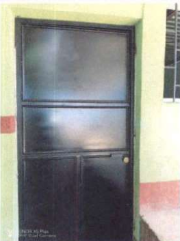
Foto 3: INSTALACIÓN DE PUERTAS
