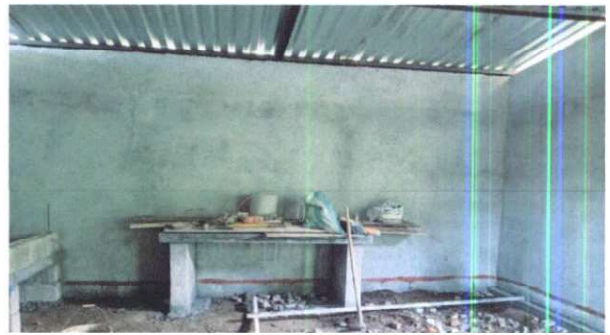
Foto 2: DISTITUCIÓN DE REPELLO Y INTERIOR
