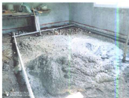
Foto 4: INSTALACIÓN DE PISO
