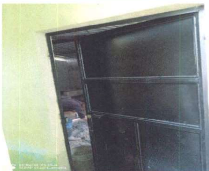
Foto 3: INSTALACIÓN DE PUERTAS
