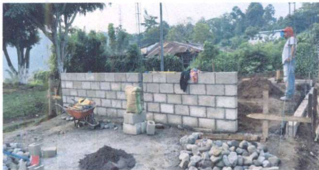
Foto 1: DSTITUCIÓN Y REPELLO EXTERIOR
