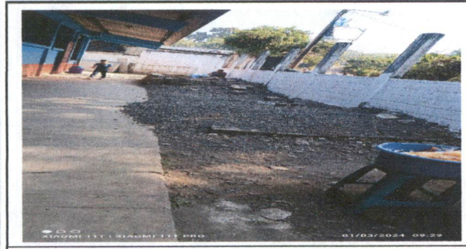
Lugar donde se instalará la nueva tubería de agua potable
