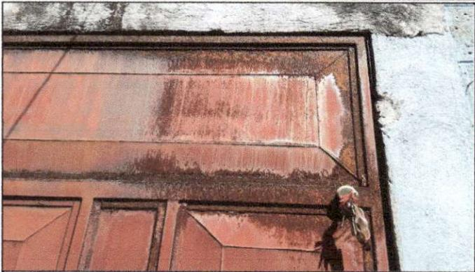
Foto 7: Estado actual de la puerta de acceso a la bodega, solicitando el cambio de esta misma ya que se encuentra en un estado muy deteriorado.
