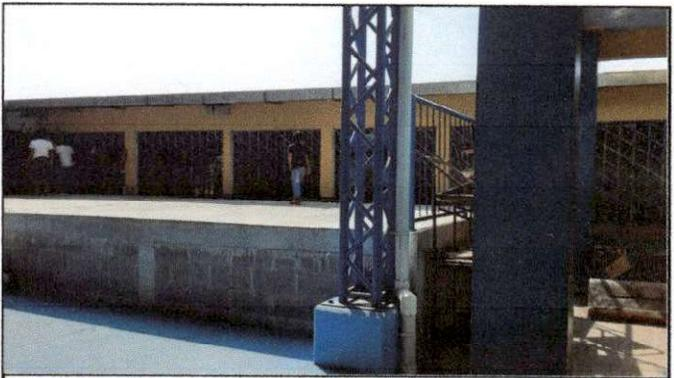
Foto 12: Se solicita colocar planchas de metal en las columnas ubicadas en la cancha, esto debido a que los niños utilizan estas columnas para trepar, poniendo en riesgo su seguridad.
