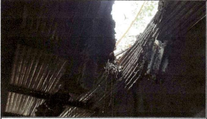
Foto 9: Solicitando el cambio de la cubierta de lámina, ya que su estado actual ha dejado inhabilitada la bodega.
