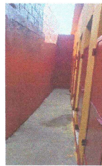
Foto 10: Pintura en muros interiores y exteriores de los sanitarios y mantenimiento de puertas.
