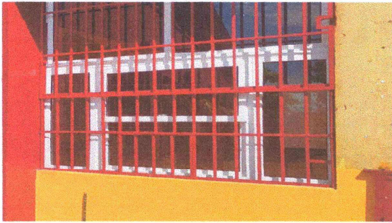
Foto 7: Instalación de ventana de UPVC de 2.20 x 3.20 mt con sistema de Guillotina.
