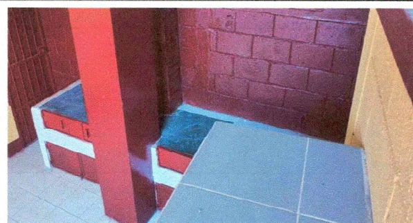
Foto 4: Pintura en muros interiores y exteriores de la cocina.
