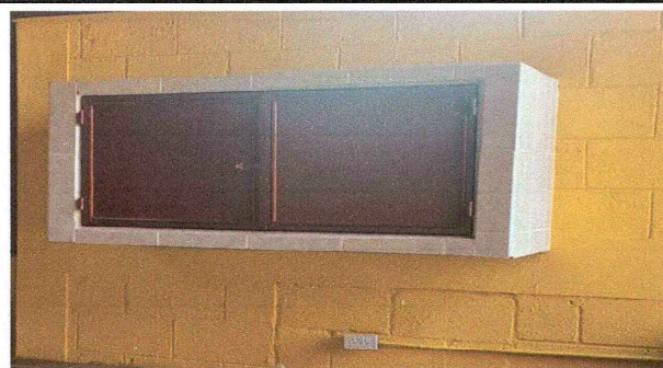
Foto 2: Instalación de gabinete de cocina con sus respectivas puertas y nueva instalación eléctrica.
