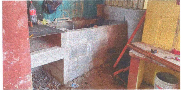
Foto 8: Instalación de nueva pila con mayor amplitud que la anterior
