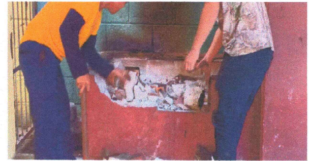
Foto 2: Se empieza con la demolición de la estufa rural.
