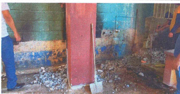
Foto 3: Se remueve totalmente la estufa rural y la pila para la sustitución de la misma.
