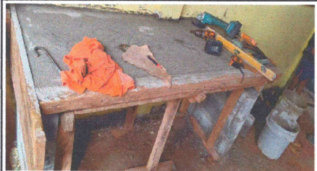
Foto 4: Se inicia con los trabajos de instalación de mesa de trabajo para facilitar el trabajo de las cocineras.
