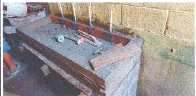
Foto 12: Sustitución de pila por un lavamanos múltiple
