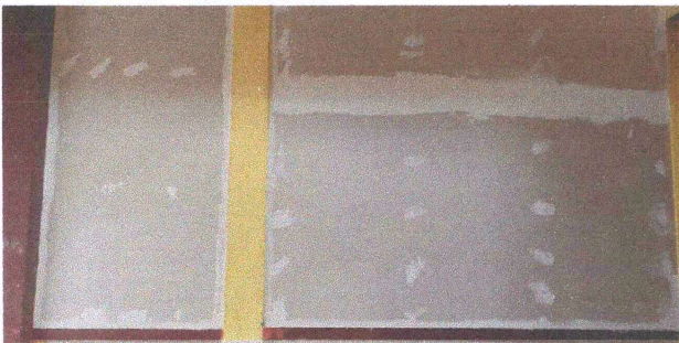
Foto 11: Colocación de tablayeso para evitar conexión de la cocina con el aula que se encuentra a la par.
