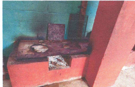
Foto 6: La estufa ya no cuenta con chimenea por deterioro, la plancha está doblada, la base de la estufa está rajada y el humo se esparce en toda la cocina.
