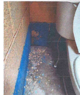
Foto 12: El piso de los sanitarios es de cemento rústico.
