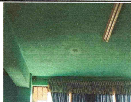
Impermeabilización de Loza
