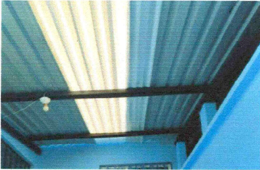
Cambio de lamina en cocina
