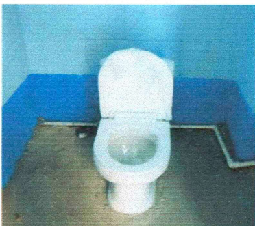
Sustitución de Inodoro
