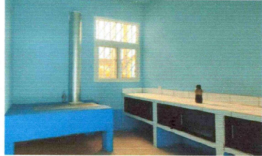
Sustitución de Estufa Rural, pintura en exteriores e interiores , repello y cernido en cocina.
