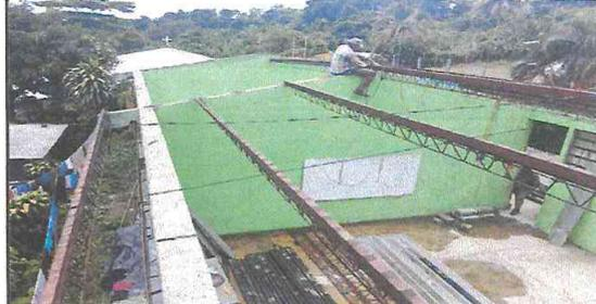
Sustitución de soporte tipo joist por costanera de metal
