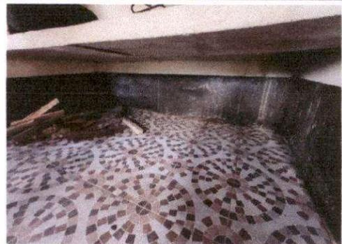
Foto 6: Sellado de filtración de agua y repello de pared de cocina.
