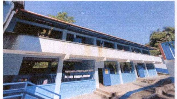
Foto 4: Extensión de cubierta de lámina y estructura de techo de segundo nivel. Pintura en muros. Sellado de filtración de agua de terraza. Cambio de 4 chapas a puertas segundo nivel.
