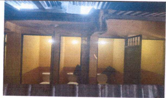
Foto 4: Instalación de energía eléctrica en sanitario.
