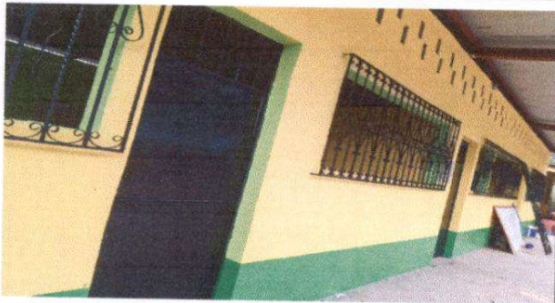
Foto 3: Pintura en muros exteriores e interiores de aulas.
