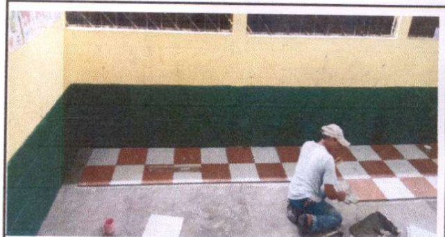
Foto 6: Sustitución de torta de concreto por piso cerámico en aula.
