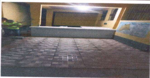
Foto 5: Suministro de mueble fijo de concreto, revestido de azulejo área exterior de cocina y sustitución de torta de concreto.
