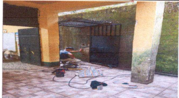
Foto 2: Sustitución de puerta de metal en sanitarios, aulas y cocina.
