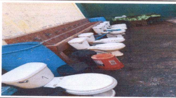
Foto1: Sustitución de inodoros.
