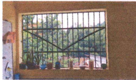
Foto 6: Suministro de ventanas de mill finish y vidrio de 5 mm.
