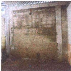
Foto 5: Repello de muro perimetral.
