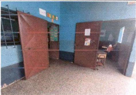
Foto 5: Mantenimiento a estructura de puertas de metal de 2.10 x 1 mt. de aulas. Suministro de chapa a puertas de metal con pasador en aulas. Pintura en muros exteriores e interiores.
