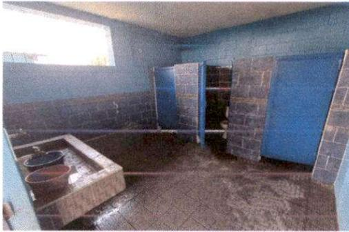
Foto 3: Reparación de losa de techo. Sustitución de inodoros. Reparación de mingitorio. Mantenimiento a estructura de puertas de metal de 0.60 x 1.51 mt. Suministro de puerta de metal de 2.10 x 1 mt.
