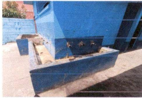
Foto 4: Reparación de grifos de pileta exterior de servicios sanitarios y suministro de azulejo a mueble de concreto. Suministro de bomba de agua. Suministro de bajada de agua pluvial de PVC 3" sanitarios.
