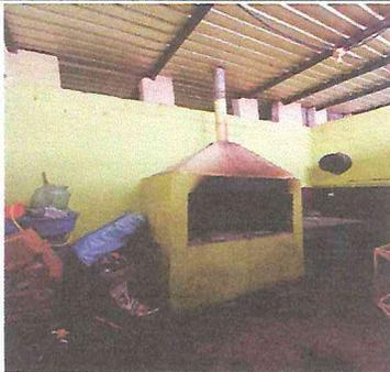
Foto 5: Reparación de chimenea de metal. Suministro e instalación de azulejo. Sustrucción de piso de cemento líquido.
