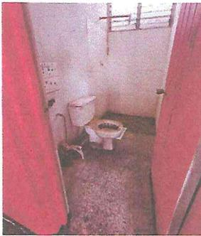
Foto 3: Sustrucción de azulejo de baño. Sustrucción de puerta de madera por puerta de metal. Sustrucción de inodoro. Suministro de lavamanos.
