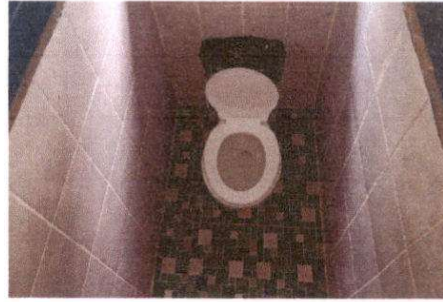
Foto 2: Sustitución de inodoro.
