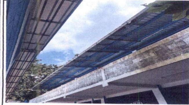
Foto 1: Extensión de cubierta de lámina troquelada aluzinc calibre 26 en segundo nivel de aulas. Suministro de estructura de soporte de metal en segundo nivel de aulas.
