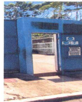
Foto 12: Mantenimiento a puerta de entrada principal
