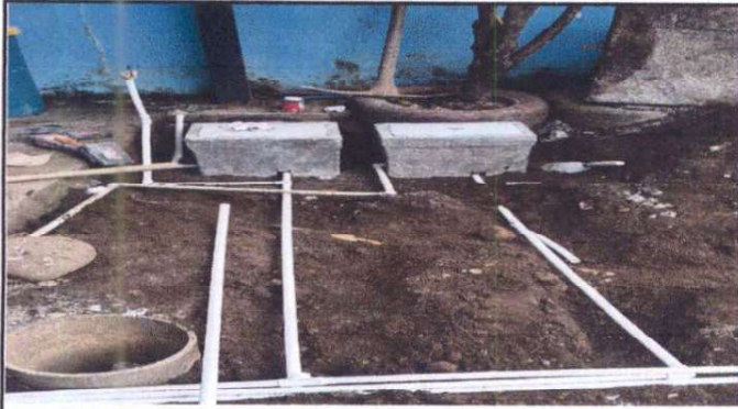
Foto 13: Sustrucción de tubería PVC línea principal
