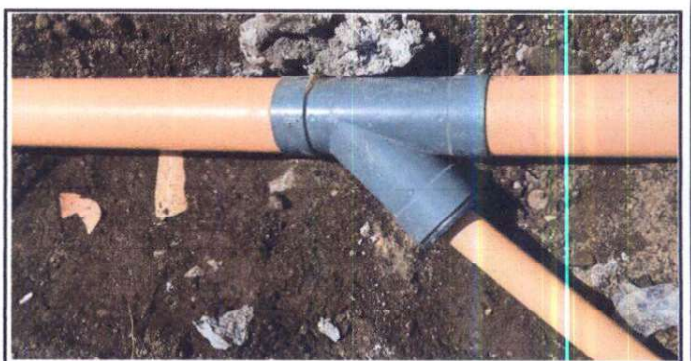
Foto 12: Sustitución de tubería PVC línea principal aguas negras
