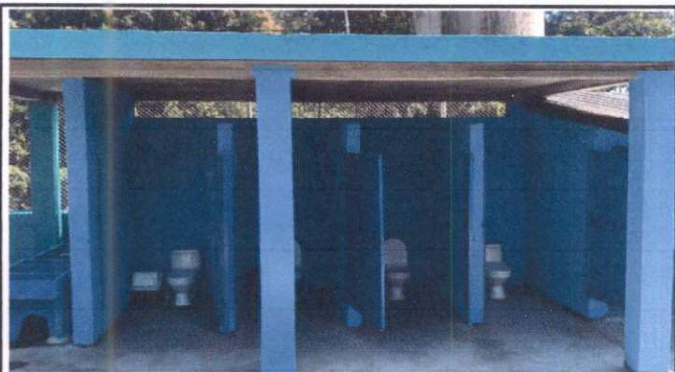
Foto 21: Cernido Gris parte interior en muros de sanitarios 14 ML
