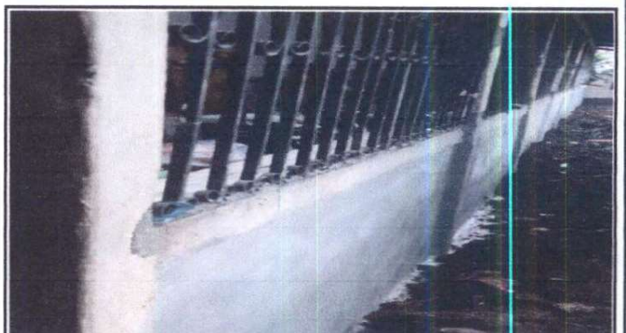
Foto 16: Repello en muro exterior parte trasera del aula
