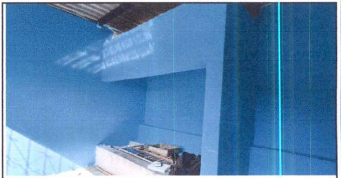
Foto 6: Pintura en muros interiores de cocina
