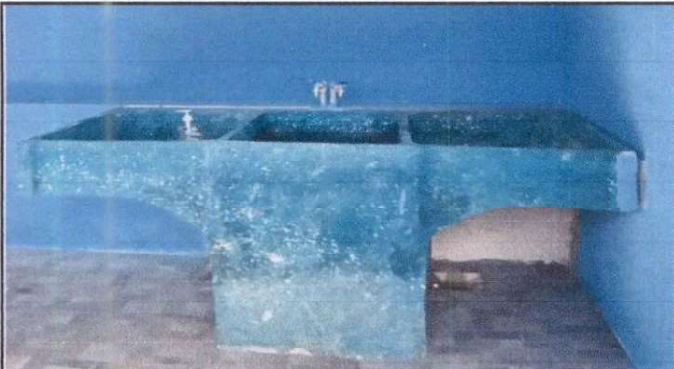
Foto 3: Sustitución de pila de concreto de 2 lavaderos
