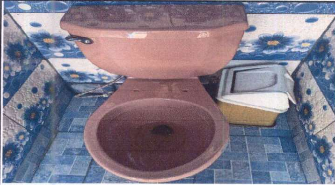
Foto7: Sustitución inodoro incluye accesorios
