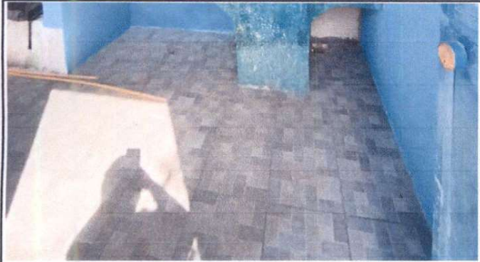
Foto1: Instalación piso cerámico antideslizante
