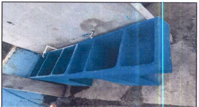
Foto 10: Instalación y Sustitución de pila Baby de concreto de 2 lavaderos con drenaje
