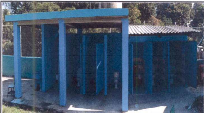
Foto 9: Pintura interior y exterior en sanitarios
