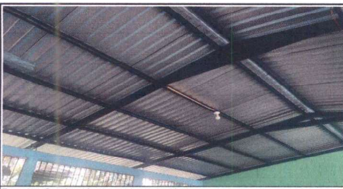
Foto 17: Sustrucción de cubierta de lámina, por lámina troquelada aluzinc calibre 26
