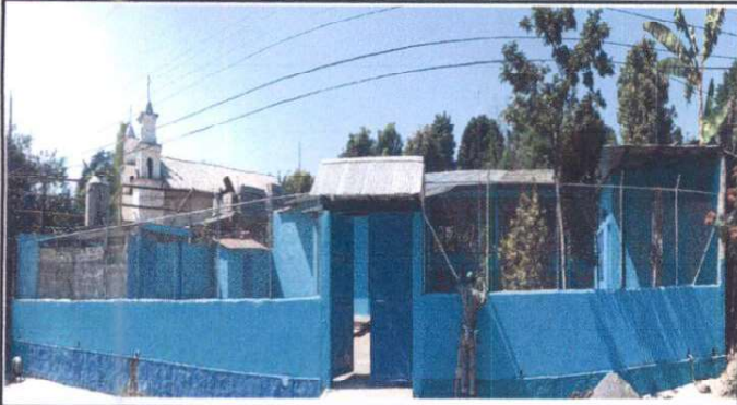
Foto 19: Reparación de muro perimetral de block con tubo hg y malla galvanizada, soleras intermedias y columnas
