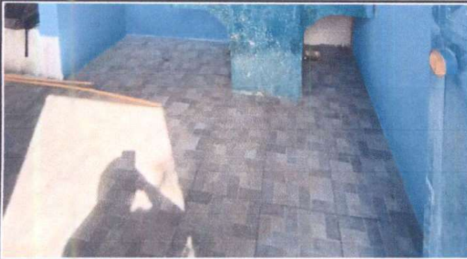
Foto1: Instalación piso cerámico antideslizante
