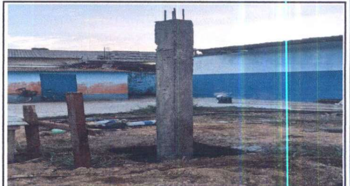
Foto 22: Instalación de Galera en patio
