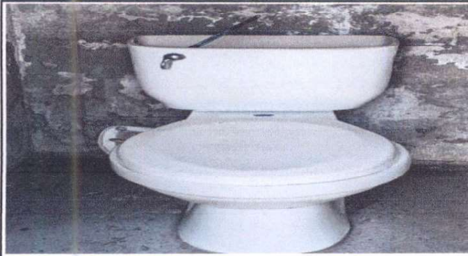
Foto7: Sustitución inodoro incluye accesorios
