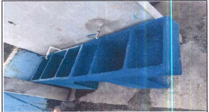
Foto 10: Instalación y Sustitución de pila Baby de concreto de 2 lavaderos con drenaje
