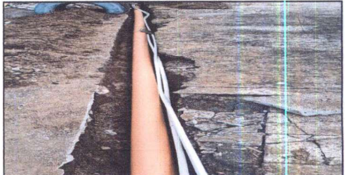
Foto 12: Sustitución de tubería PVC línea principal aguas negras
