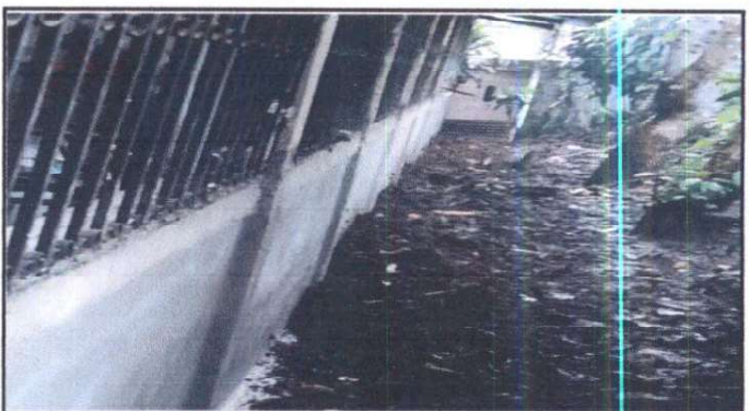
Foto 16: Repello en muro exterior parte trasera del aula
