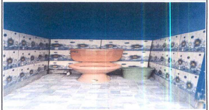
Foto 8: Suministro e Instalación de piso Azulejo en sanitarios
