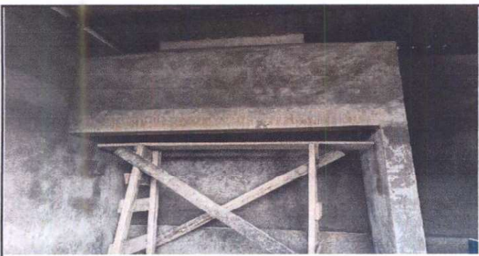
Foto 5: Repello y cernido en muros interiores de cocina
