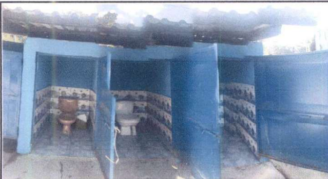
Foto 9: Pintura interior y exterior en sanitarios
