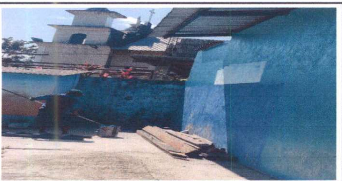
Foto 23: Pintura en muros exteriores del edificio escolar
