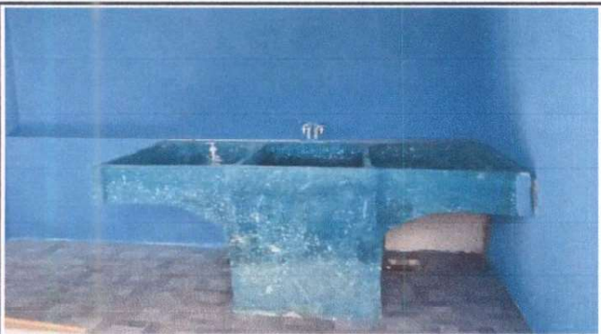
Foto 3: Sustitución de pila de concreto de 2 lavaderos
