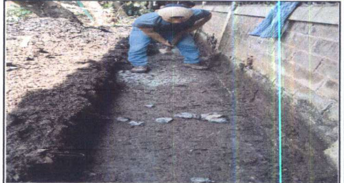
Foto 20: Instalación de Drenaje Frances 32 ML
