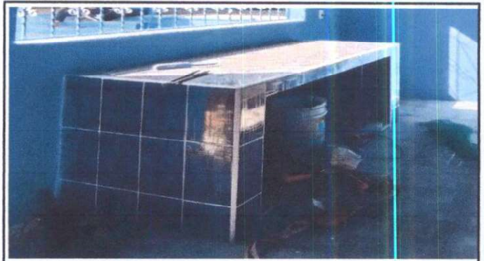
Foto 2: Suministro e instalación de Azulejo en mesa de concreto de cocina
