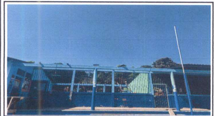
Foto 15: Sustrucción de estructura de soporte de lámina, por lámina troquelada aluzinc calibre 26 en porton principal
