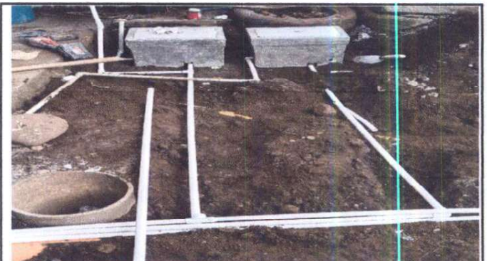
Foto 4: Sustitución de tubería PVC aguas negras
