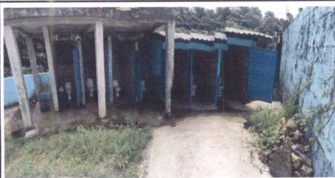
Foto 9: Pintura interior y exterior en sanitarios
