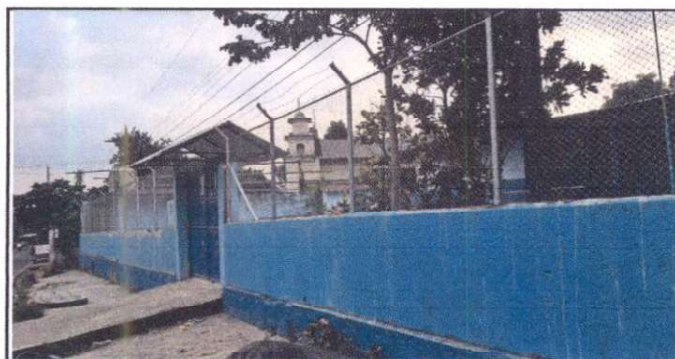
Foto 23: Pintura en muros exteriores del edificio escolar
