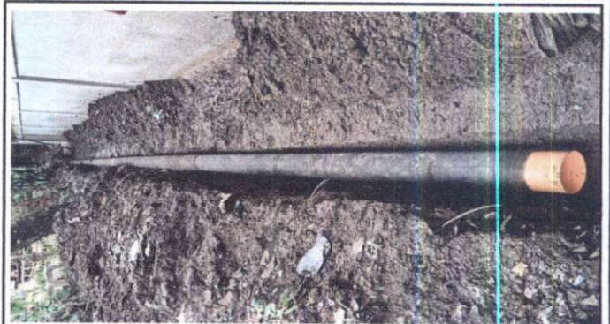
Foto 20: Instalación de Drenaje Frances 32 ML
