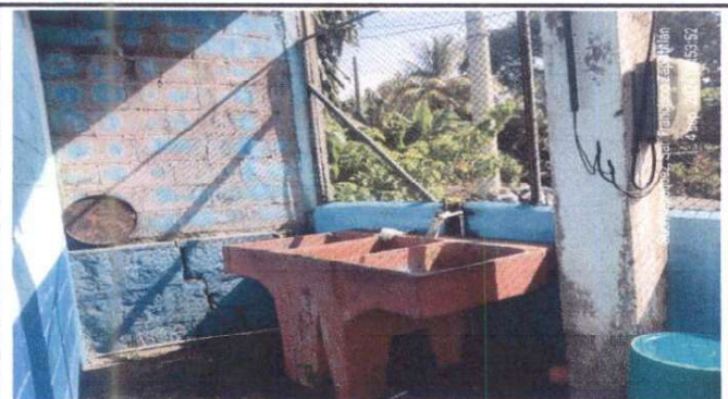
Foto 3: Sustitución de pila de concreto de 2 lavaderos
