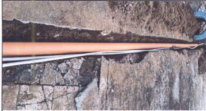
Foto 13: Sustrucción de tubería PVC línea principal
