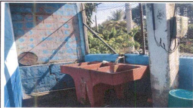
Foto 3: Sustitución de pila de concreto de 2 lavaderos
