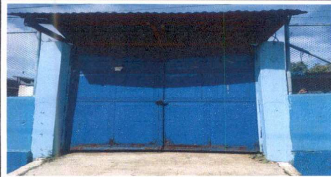
Foto 13: Mantenimiento portón principal de metal de 3.00 x 3.50
