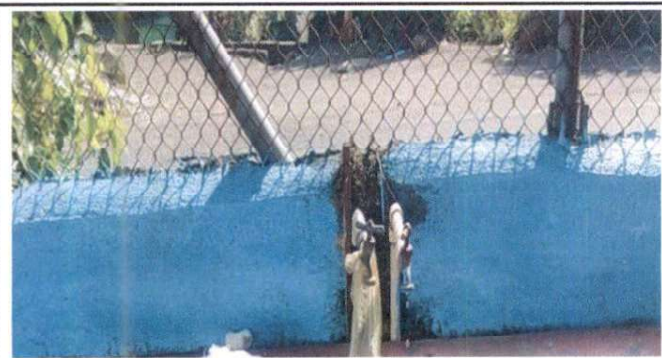
Foto 11: Sustitución de llave de chorro
