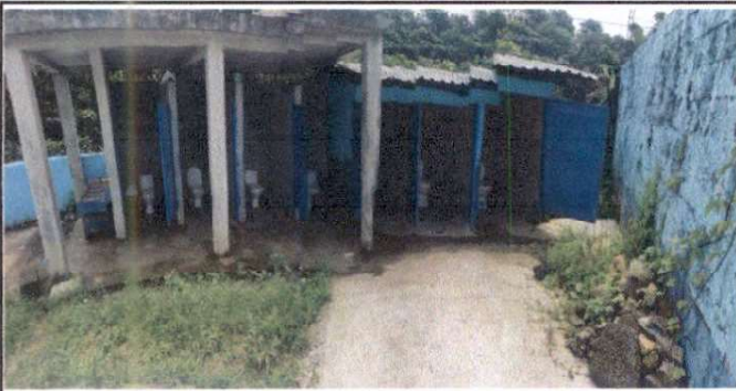
Foto 9: Pintura interior y exterior
