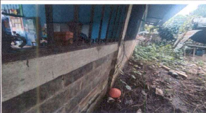
Foto 15: Repello en muro exterior parte trasera del aula
