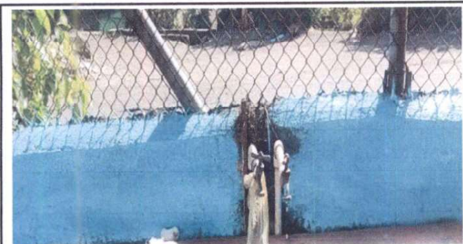
Foto 11: Sustitución de llave de chorro
