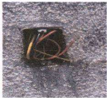
Foto 7: Sustitución de toma corrientes y apagadores
