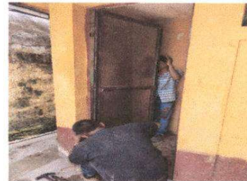
Foto 4: Sustitución de puerta de baño
