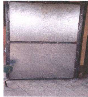
Foto 2: Sustitución puerta grande aula formal
