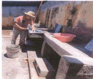
Foto 9: Sustitución de pila de cemento de un lavadero
