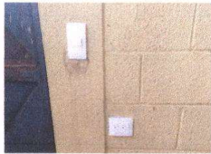
Foto 7: Sustitución de toma corrientes y apagadores
