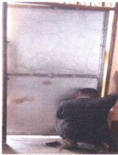
Foto 3: Sustitución de puerta de aula pequeña informal
