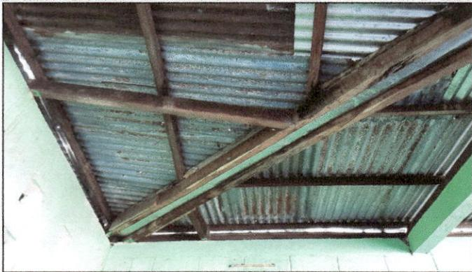
Foto 7: Estado actual de la estructura de madera, solicitan el cambio de esta misma por una estructura metálica.
