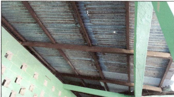
Foto 3: Estado actual de la cubierta de lámina, solicitan el cambio de esta misma ya que se encuentra muy deteriorada.
