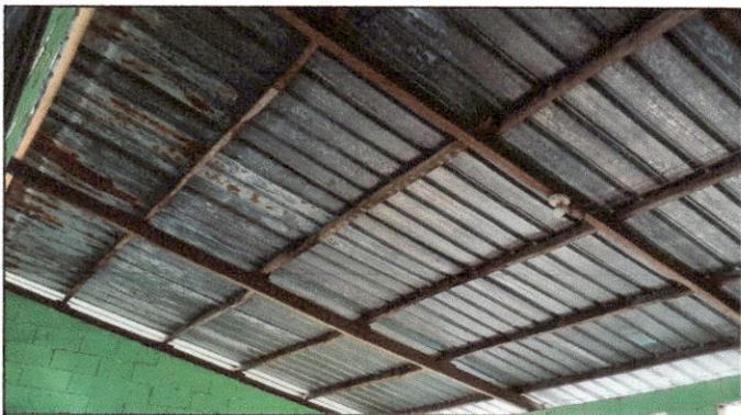
Foto 5: Solicitan el cambio de cubierta de lámina, ya que esta se encuentra muy deteriorada en gran parte del establecimiento.
