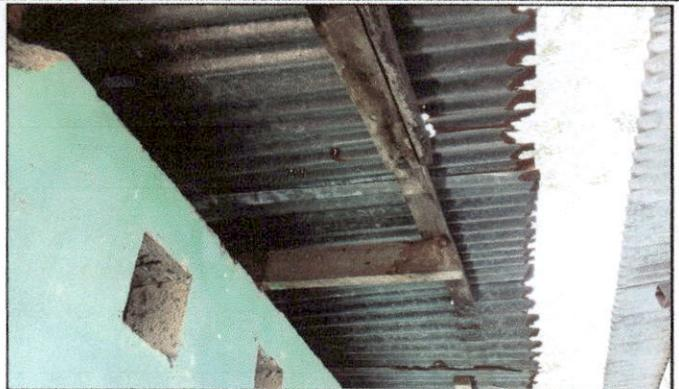
Foto 8: Estado actual de la estructura de madera, solicitan el cambio de esta misma por una estructura metálica.
