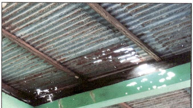
Foto 6: Solicitan el cambio de cubierta de lámina, ya que esta se encuentra muy deteriorada en gran parte del establecimiento.
