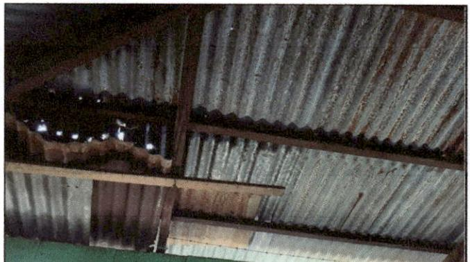
Foto 4: Estado actual de la cubierta de lámina, solicitan el cambio de esta misma ya que se encuentra muy deteriorada.
