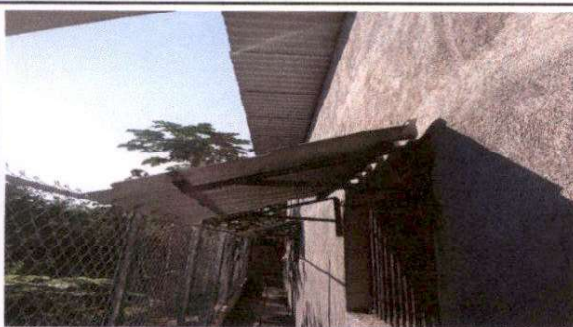
Foto 9: Instalación de vicerias de lámina arquiteja en ventana de 2.40 metros
