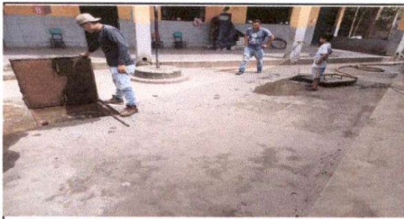
Foto 12: Limpieza de fosa séptica dimensiones según plano 3.5 x 3.5 x 2.6= 31.85 m3 incluye extracción y disposición adecuada en lodo
