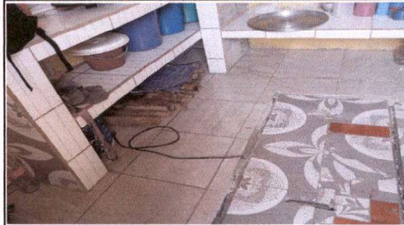
Foto 2: Sustitución de piso cerámico
