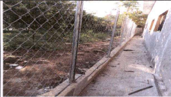
Foto 13: Sustitución de alambre espicado y postes de madera por tubo Hg y malla galvanizada.
