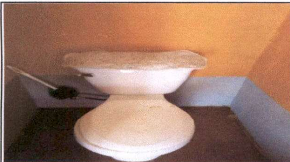
Foto 3: Sustitución de accesorios inodoro (contra llave, tubo de abasto y tanque)
