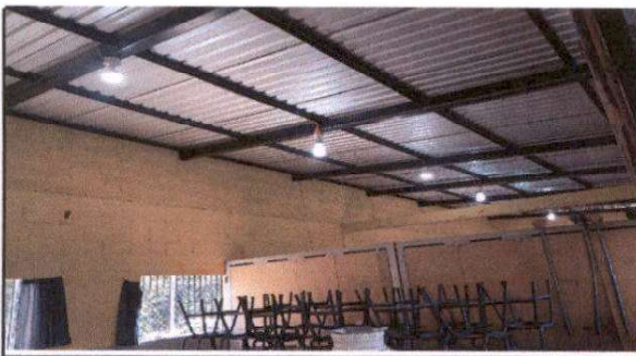
Foto 11: Sustitución de ducto eléctrico más cableado y accesorios.
