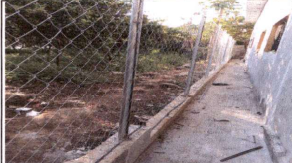
Foto 8: Instalación de piso torta de cemento exterior trasero aula módulo 2
