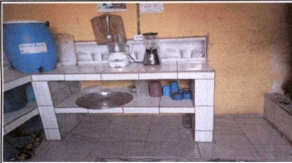
Foto 1: Instalación de gabinete de concreto armado
