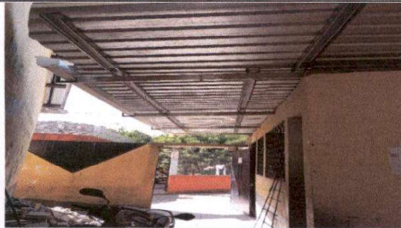
Foto 7: Sustitución de lamina, por lamina troquelada calibre 26 de 7 pies.
