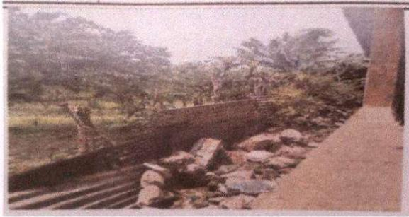
Foto 13: Sustitución de alambre espicado y postes de madera por tubo Hg y malla galvanizada.
