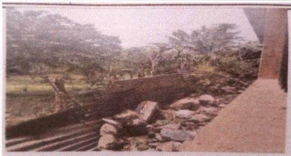
Foto 13: Sustitución de alambre espicado y postes de madera por tubo Hg y malla galvanizada.
