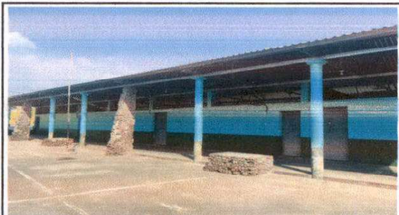
Foto 3: Sustitución de puerta de madera por metal 1.00 x 2.10 mt
