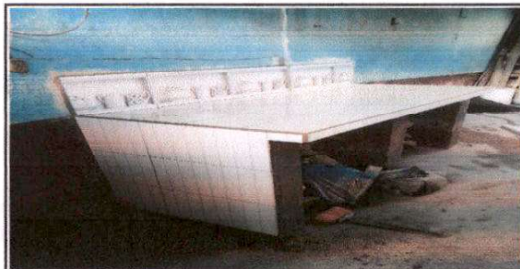
Foto 6: Instalación de Azulejo en mesa de concreto de cocina
