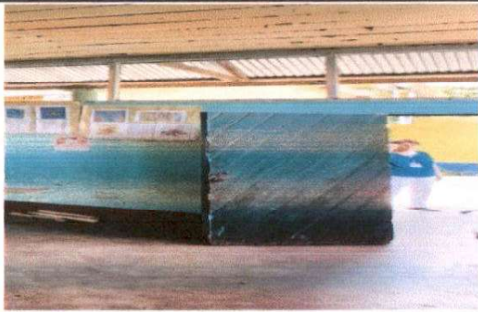
Foto 3: Sustitución de puerta de madera por metal 1.00 x 2.10 mt
