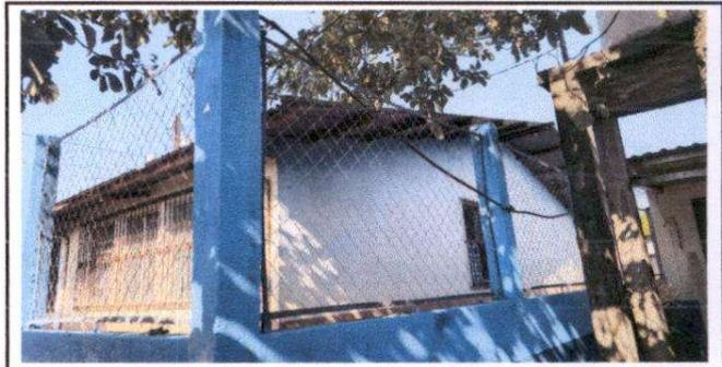
Foto 12: Sustitución de malla galvanizada en muro perimetral
