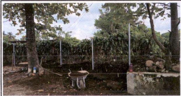
Foto 10: Sustitución de tubo hg y malla galvanizada en cerco perimetral
