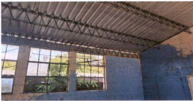
Foto 7: Pintura interior en muros de aula
