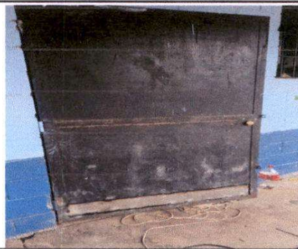
Foto 4: Mantenimiento de puertas en aula
