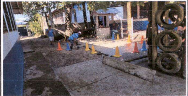
Foto 8: Reparación de torta de concreto en patio
