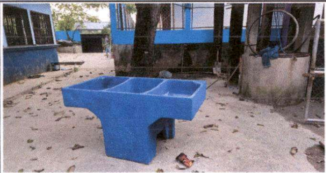
Foto 9: Sustitución de Pila de Concreto de 2 lavaderos
