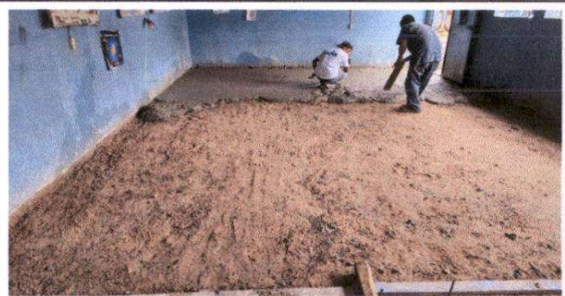
Foto 2: Reparación de piso de cemento líquido
