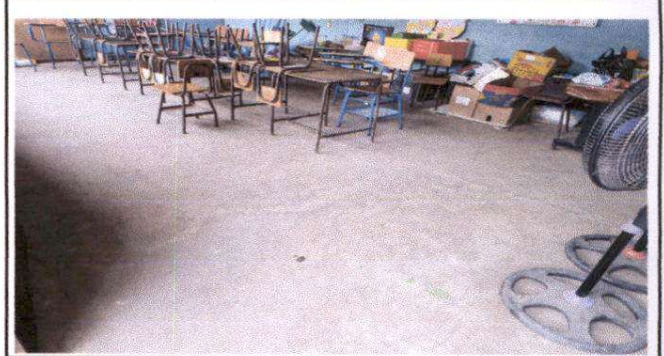
Foto 2: Reparación de piso de cemento líquido
