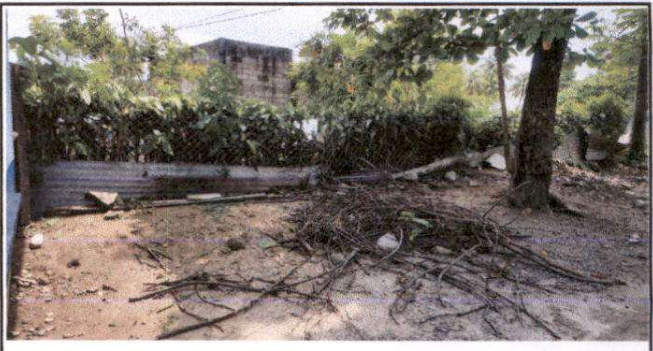
Foto 10: Sustitución de tubo hg y malla galvanizada en cerco perimetral
