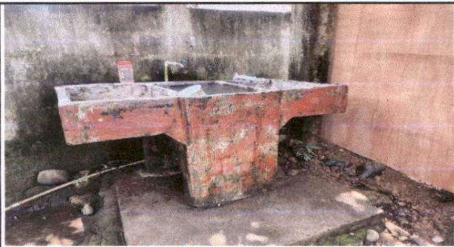
Foto 9: Sustitución de Pila de Concreto de 2 lavaderos
