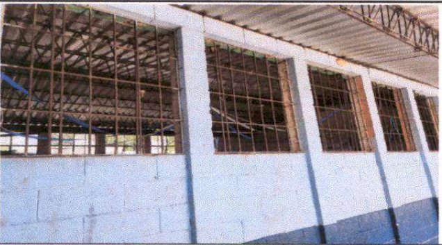
Foto 5: mantenimiento de balcones de metal parte frontal de aula
