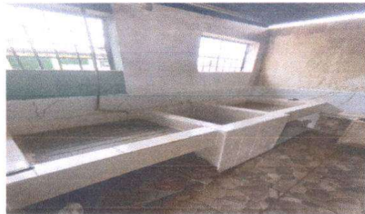
Foto 6: Sustitución de pila por pila de concreto
