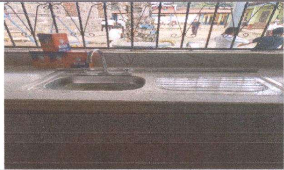
Foto 4: Sustitución de lavatrastos
