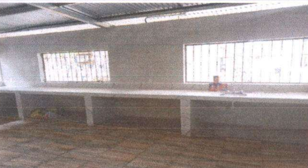
Foto 5: Sustitución de azulejos de gabinetes
