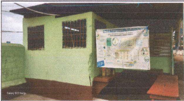
Foto 1: ampliación de cocina
