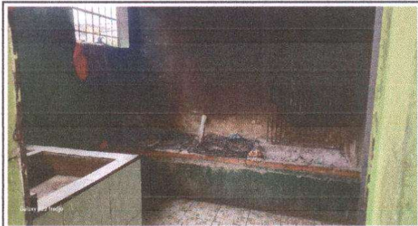
Foto 2: Sustitución de estufa rural por chimenea y estufa de concreto
