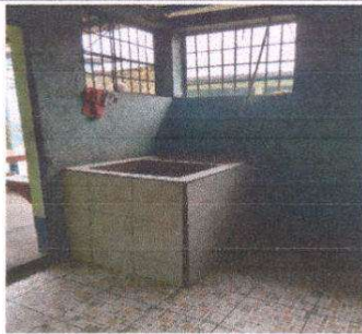
Foto 3: Sustitución de pila por pila con dos lavaderos
