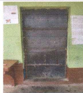
Foto 4: Mantenimiento de estructura de puerta (lijado, pintura y cambio de chapa)
