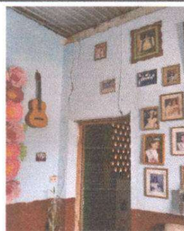
foto 9 Sellado de grietas y fisura
