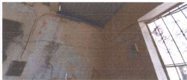
foto 11 Sustitución de ducto eléctrico
