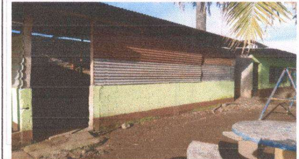
Foto 6: Sustitución de piso de concreto
