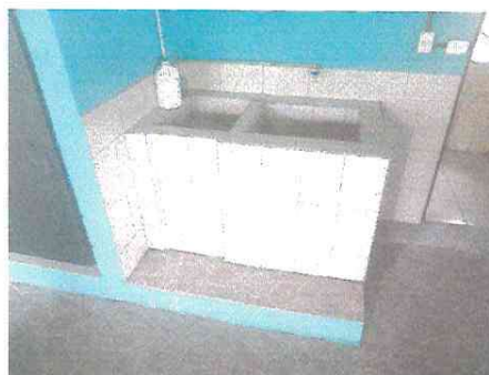
foto 4. Instalacion de azulejos en pila de cocina
