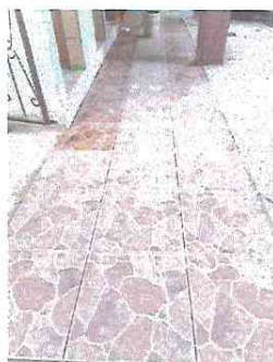
foto 5. sustitucion de piso de granito por piso antideslizante
