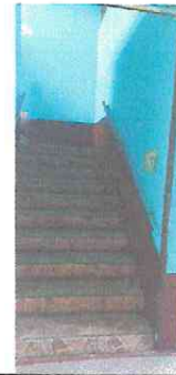
Foto 4: Instalacion de piso en gradas
