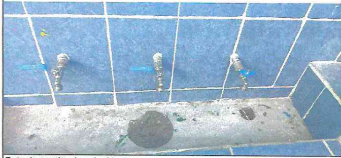
Foto 1: sustitucion de Chorros
