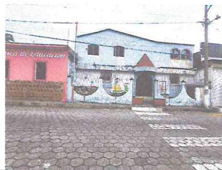
Foto 6: mantenimiento de porton principal
