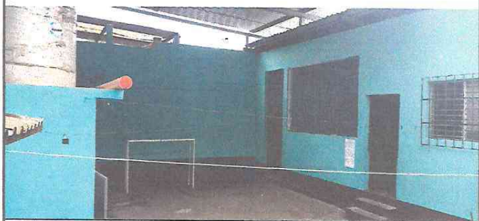
Foto 2. Pintura de paredes de la escuela
