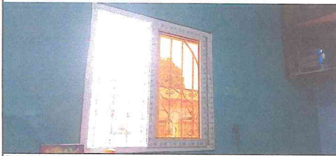
Foto 3: Sustitucion de ventana de metal por ventana de pvc.
