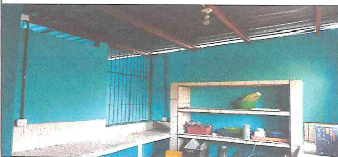
Foto 2. instalacion de azulejos en muebles de cocina
