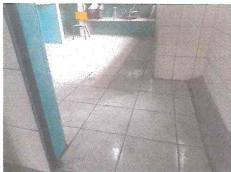
Foto 1: sustitucion de piso por piso ceramico de la cocina
