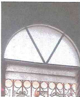
Foto 3: Sustitucion de ventana de metal por ventana de pvc.
