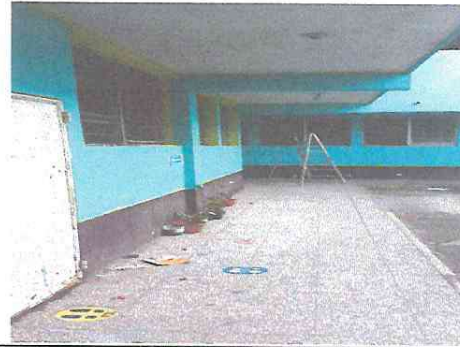
Foto 2. Pintura de paredes de la escuela
