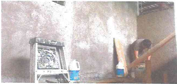
Foto 3: cernido y repero de paredes
