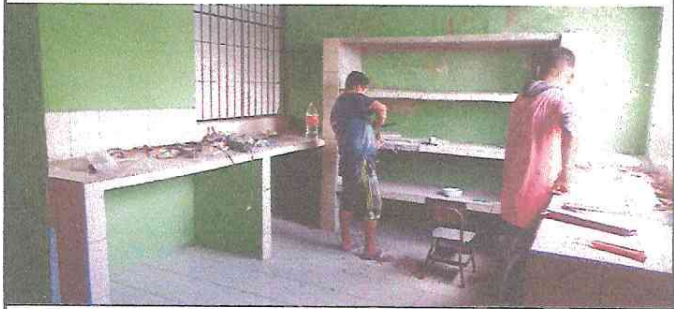
Foto 2: instalación de azulejos en muebles de cocina
