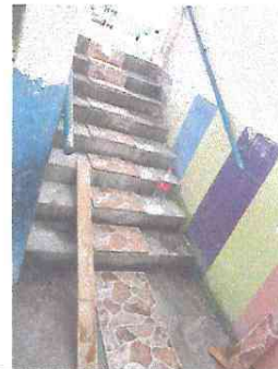
Foto 4: Instalacion de piso en gradas
