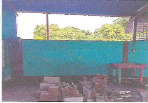
Foto 1: Demodelacion de pared e instalcion de ventana y balcon
