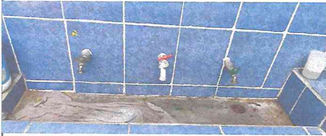
Foto 1: sustitucion de Chorros
