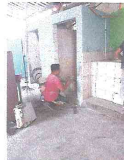
Foto 6: sustitución de dos baños, azulejos y puertad del segundo nivel
