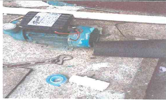
Foto 2: sustitucion de bomba de agua
