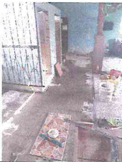
Foto 5: sustitución de piso de granito por piso antideslizante
