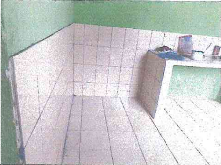
Foto 1: sustitución de piso por piso cerámico de la cocina
