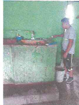
Foto 4: Instalación de azulejos en pila de cocina
