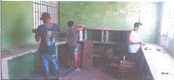
Foto 3: fabricación de mueble de cocina de concreto
