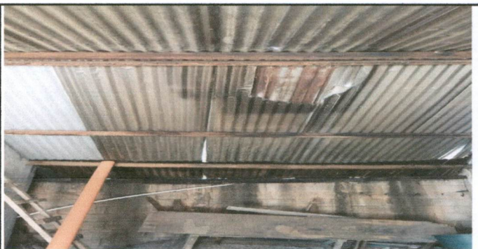
Foto 6: Sustitución de cubierta de lámina y sustitución de estructura de soporte de madera por metal
