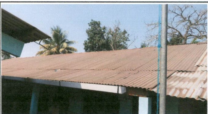
Foto 4: Sustitución de cubierta de lámina por lámina troquelada calibre 26
