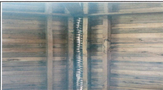
Foto 3: Sustitución de capote de lámina
