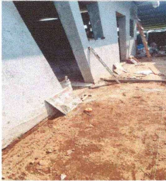
Foto 7: BANQUETA DE CONCRETO, Preparación del terreno para la colocación de concreto.
