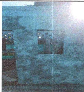
Foto 4: VENTANA Se quitó la ventana para cambiarla por metal.
