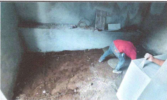
Foto 5: PISO, Se procedió a la preparación del suelo para la colocación de piso.
