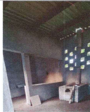
Foto 8: PINTURA EN MUROS EXTERIORES E INTERIORES, Preparación de pared antes de aplicar la pintura.
