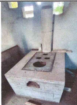
Foto 11: REPARACIÓN DE COCINA, Se procedió a la reparación de la Estufa de leña existente, se le colocó la plancha y chimenea.
