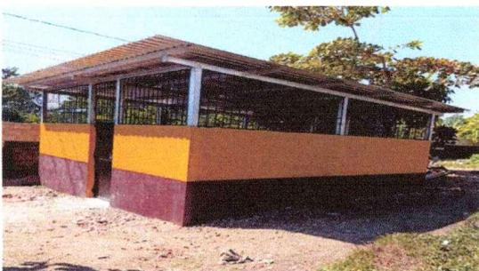
Foto 5: Cocina levantado de 4 hiladas de block
