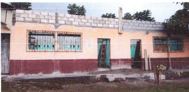
Foto 3: Aulas levantado de 3 hiladas de block
