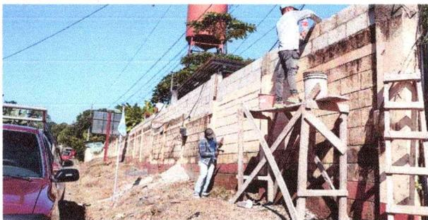
Foto 11: Muro perimetral reparación, cernido y pintado
