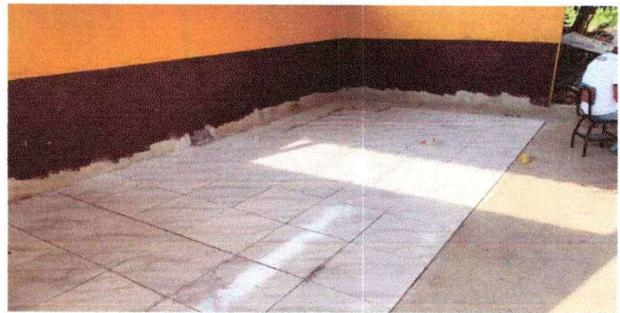
Foto 8: Sustrucción de piso de torta de concreto
