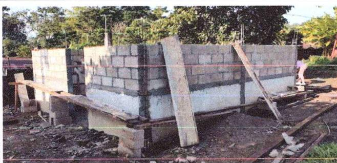
Foto 5: Cocina levantado de 4 hiladas de block
