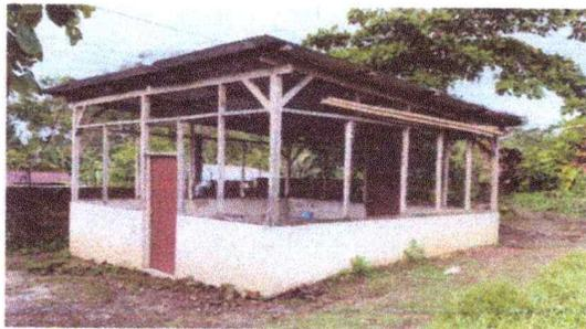
Foto 5: Cocina levantado de 3 hiladas de block
