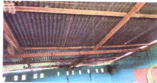
Foto 2: Aulas sustitución de estructura de soporte de madera por metal
