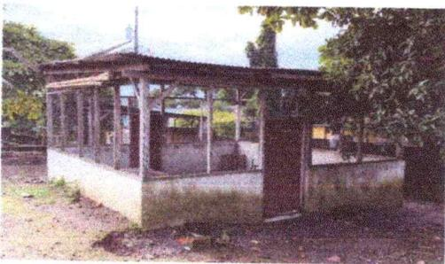
Foto 9: Cocina sustitución de malla por balcones
