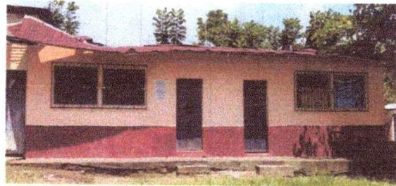
Foto 3: Aulas levantado de 3 hiladas de block
