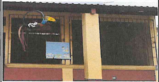
Foto 4: Mantenimiento a balcon de metal del área de cocina
