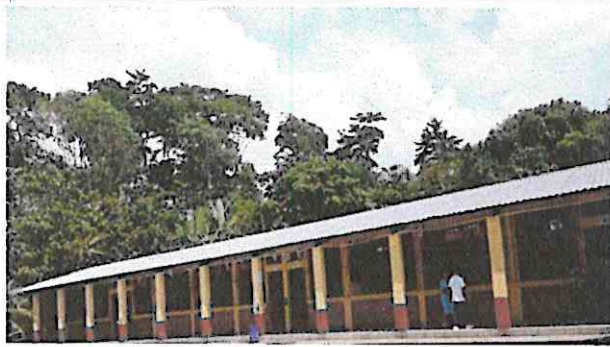
Foto1: Cubierta de lamina en dos aulas
