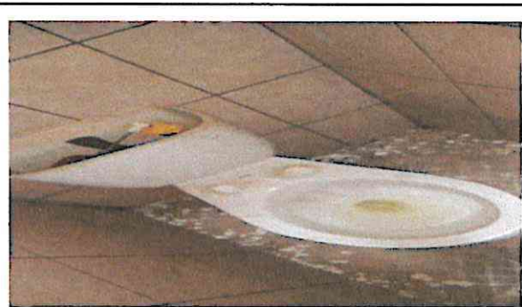
Foto 6: Sustitución de sanitarios
