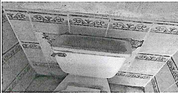
Reparación de baños y accesorios
