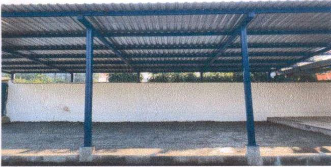
Foto 1: Sustitución de lámina, por lámina troquelada aluzinc calibre 26 de área de patio, sustitucion de piso de torta de concreto y repello de muro perimetral.
