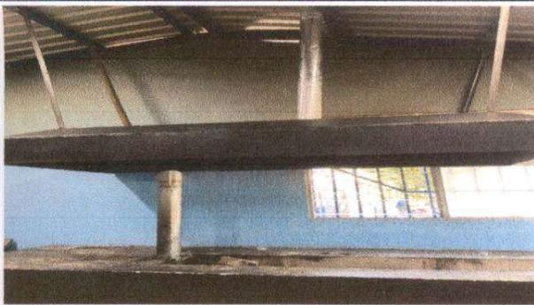
Foto 5: Sustitución e Instalacion de chimenea de metal (tipo campana)
