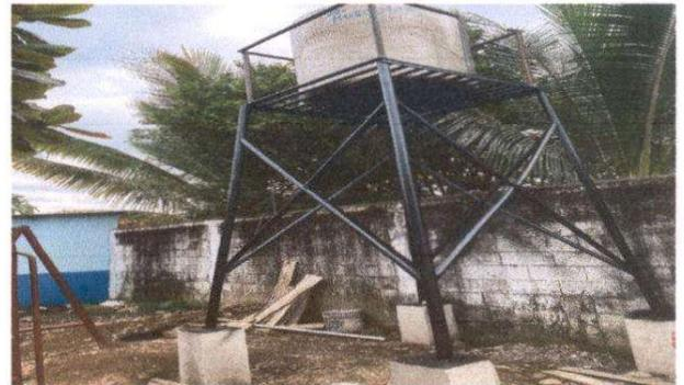
Foto 4: Sustitución de depósito de agua 1,100 lt. (incluye accesorio), Suministro e instalación de base de concreto y estructura de metal y de deposito de agua.
