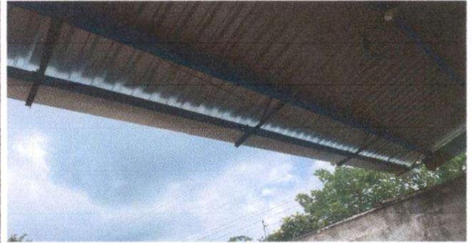
Foto 2: sustitucion e instalación de canal de metal.
