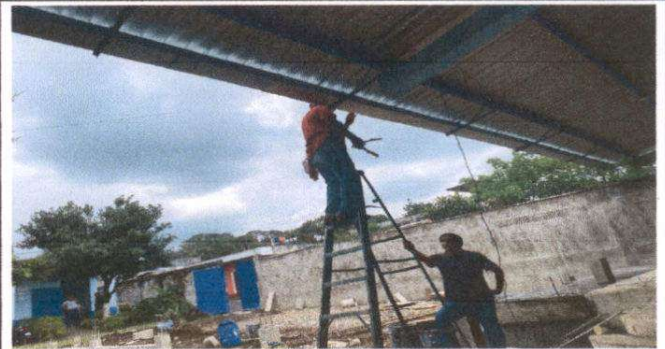
Foto 2: sustitucion e instalación de canal de metal.
