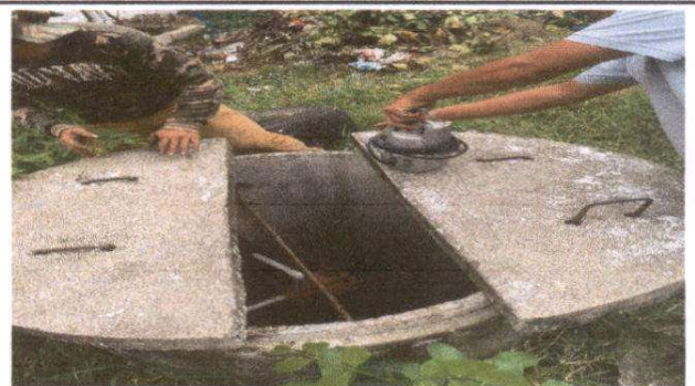
Foto 6: Sustitución de bomba de agua de 1HP
