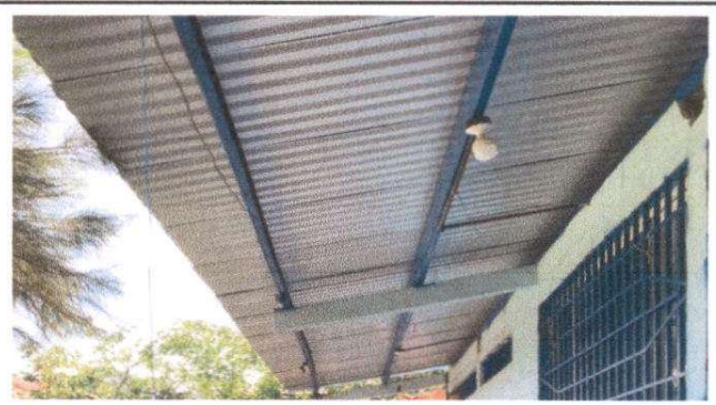
Foto 2: Sustitución e instalación de canal de metal
