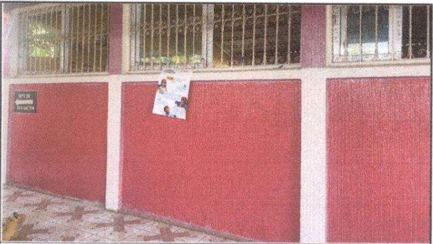
Foto 3: En la fotografía se logra apareciar el cambio que tuvieron las paredes del centro educativo y con ello se logra una mejor preservación y cuiddo del inmueble.
