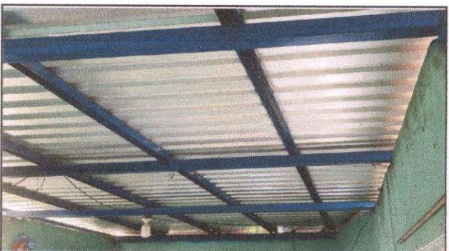
Foto 4: La imagen muestra el trabajo realizado con el cambio de lámina troquela, lo cual mejorará el ambiente en las aulas, ya que con ello disminuye el calor y se logra una mejor protección de la lluvia.
