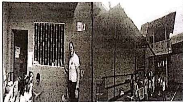
Foto 3: Suministro e instalación de ventanas corredizas de aulas.
