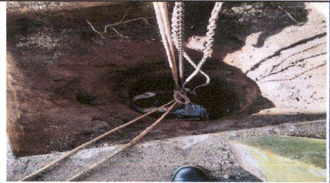
Foto 4: Pozo artesanal con mal funcionamiento
